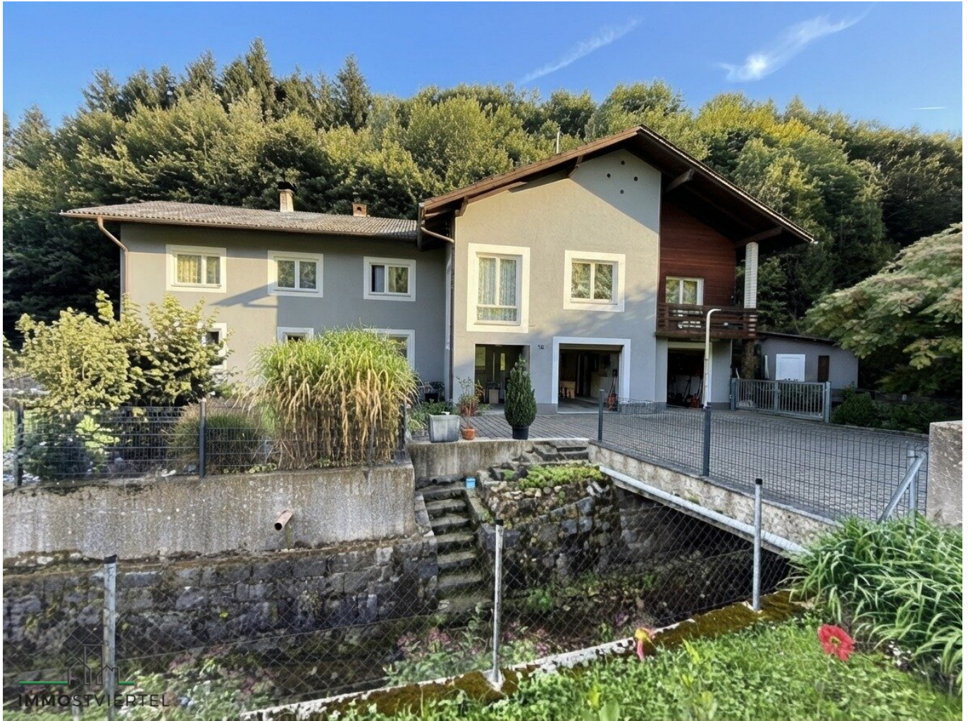
Ansicht von Straßenseite
