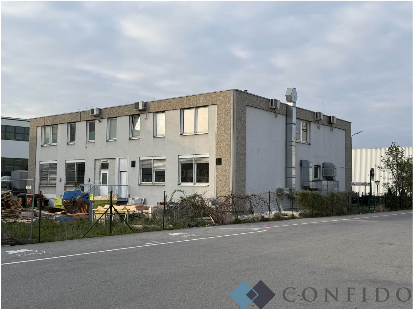
Ansicht Rückseite (vom Nachbarn aus)
