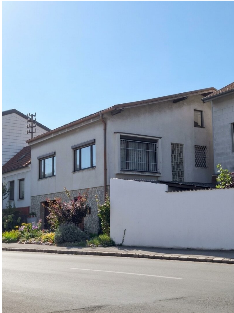
Straßenansicht des Hauses
