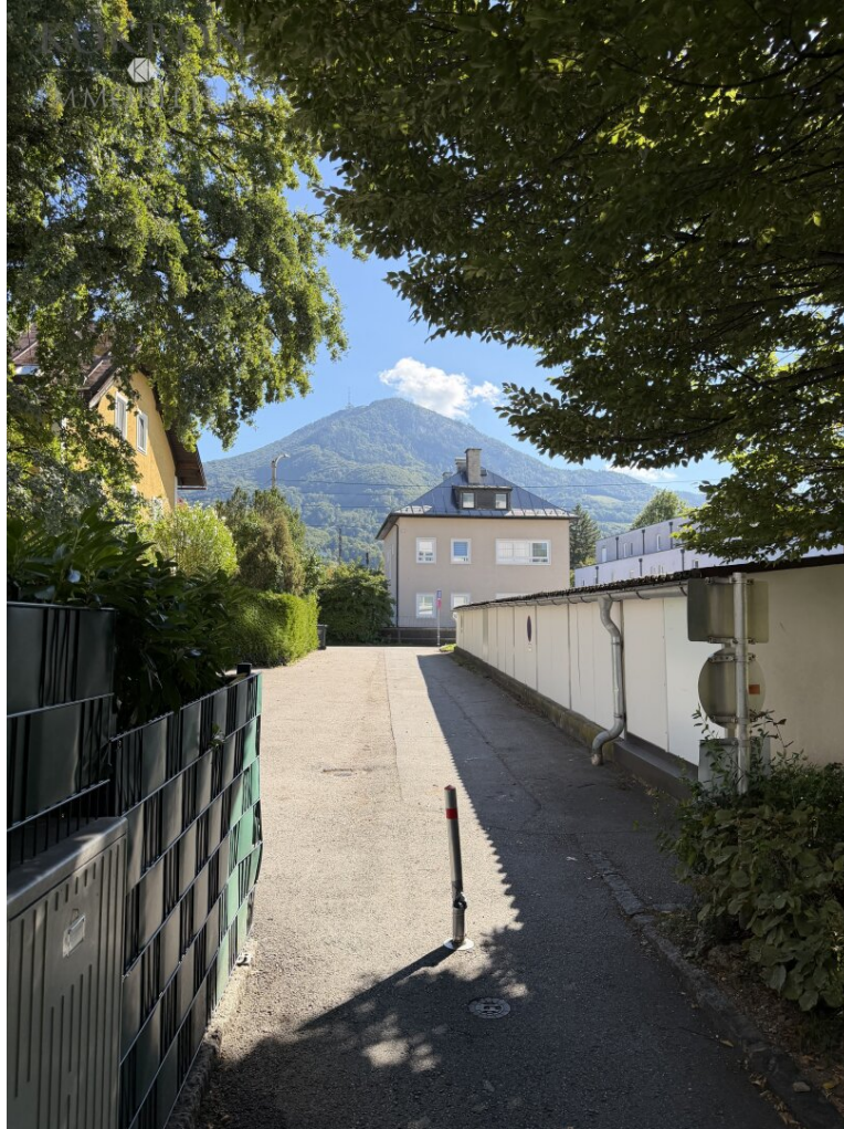
Zugang mit Blick auf Gaisberg
