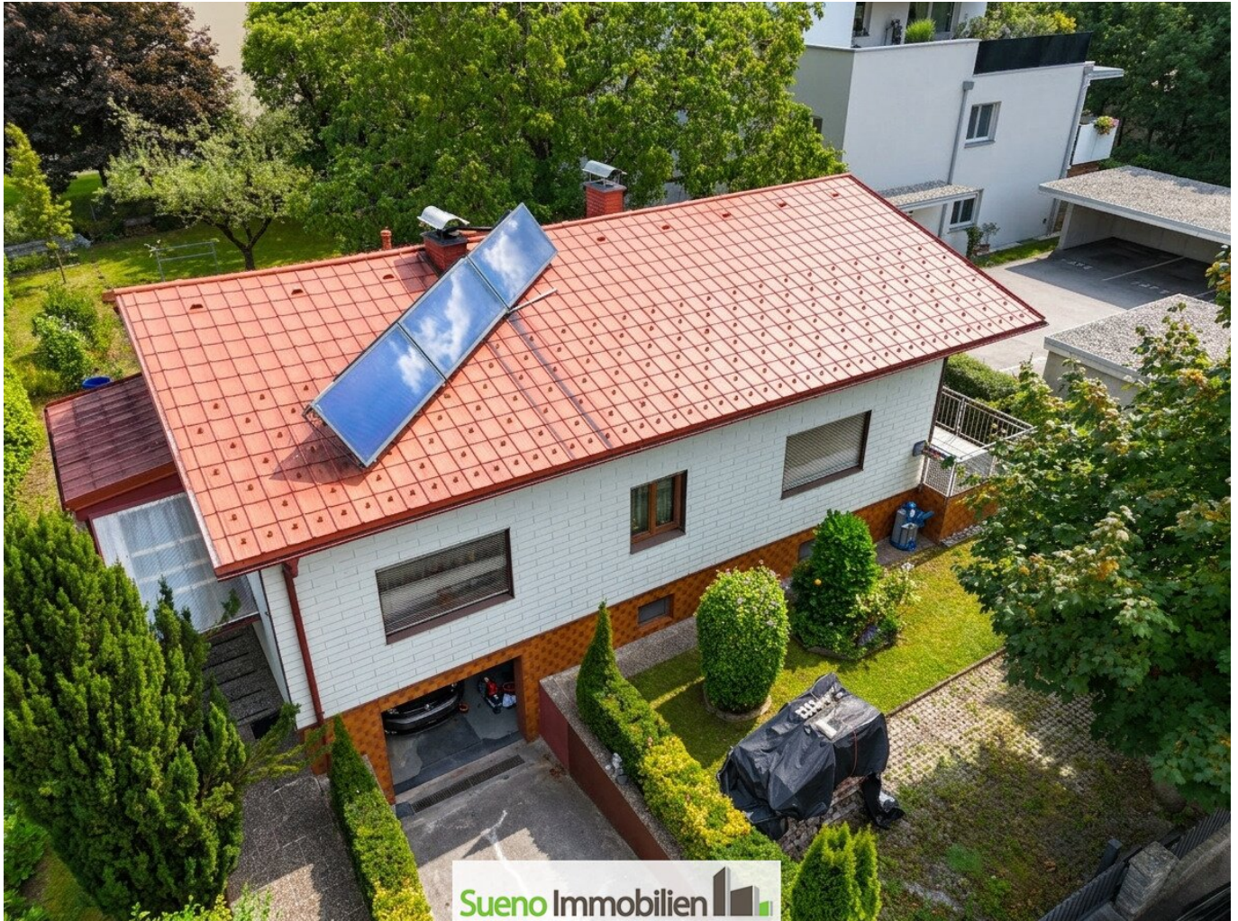
Drohnenbild mit Prefa-Dach und Solar-Anlage
