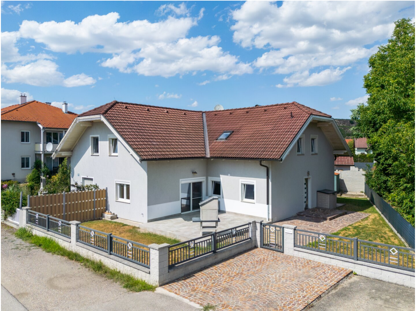
Ansicht der Doppelhaushälfte
