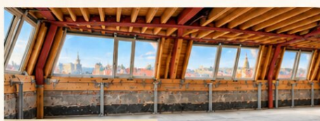
AKTUELLER ZUSTAND – ROHBAU
