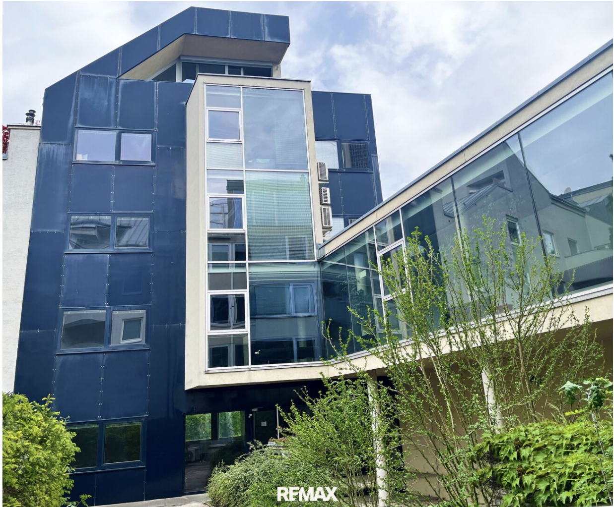
Haus Ost Ansicht
