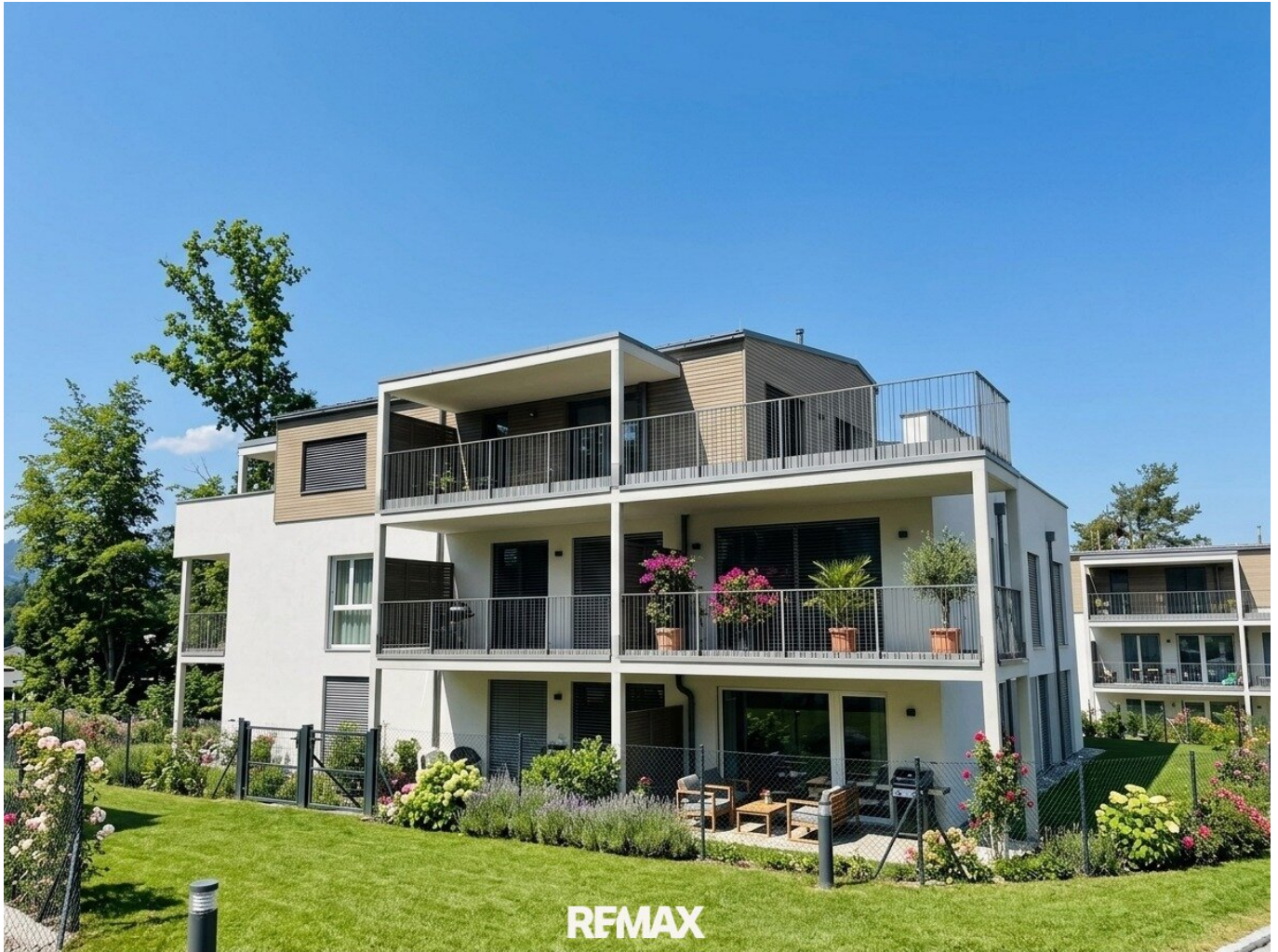
Ansicht der Wohnanlage
