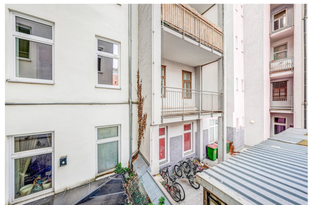
Blick vom Wohnzimmer in den Innenhof
