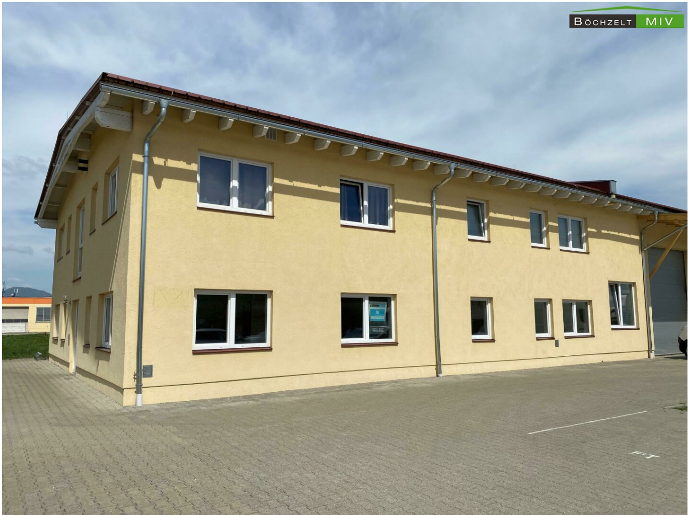
Bürohaus in Klagenfurt
