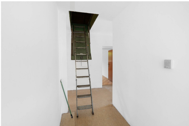
Runterklappbare Leiter im Flur zum Dachboden
