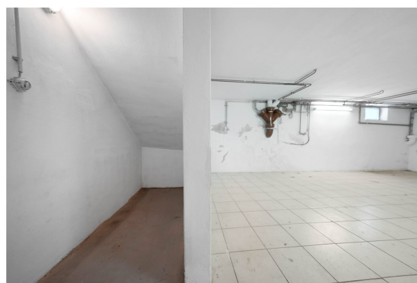
Zusätzlicher Stauraum unter den Kellerstiegen
