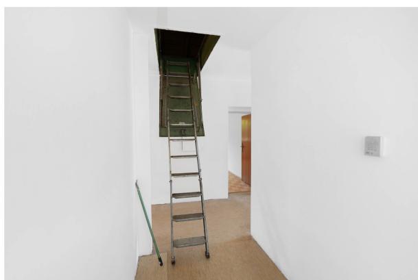
Runterklappbare Leiter im Flur zum Dachboden
