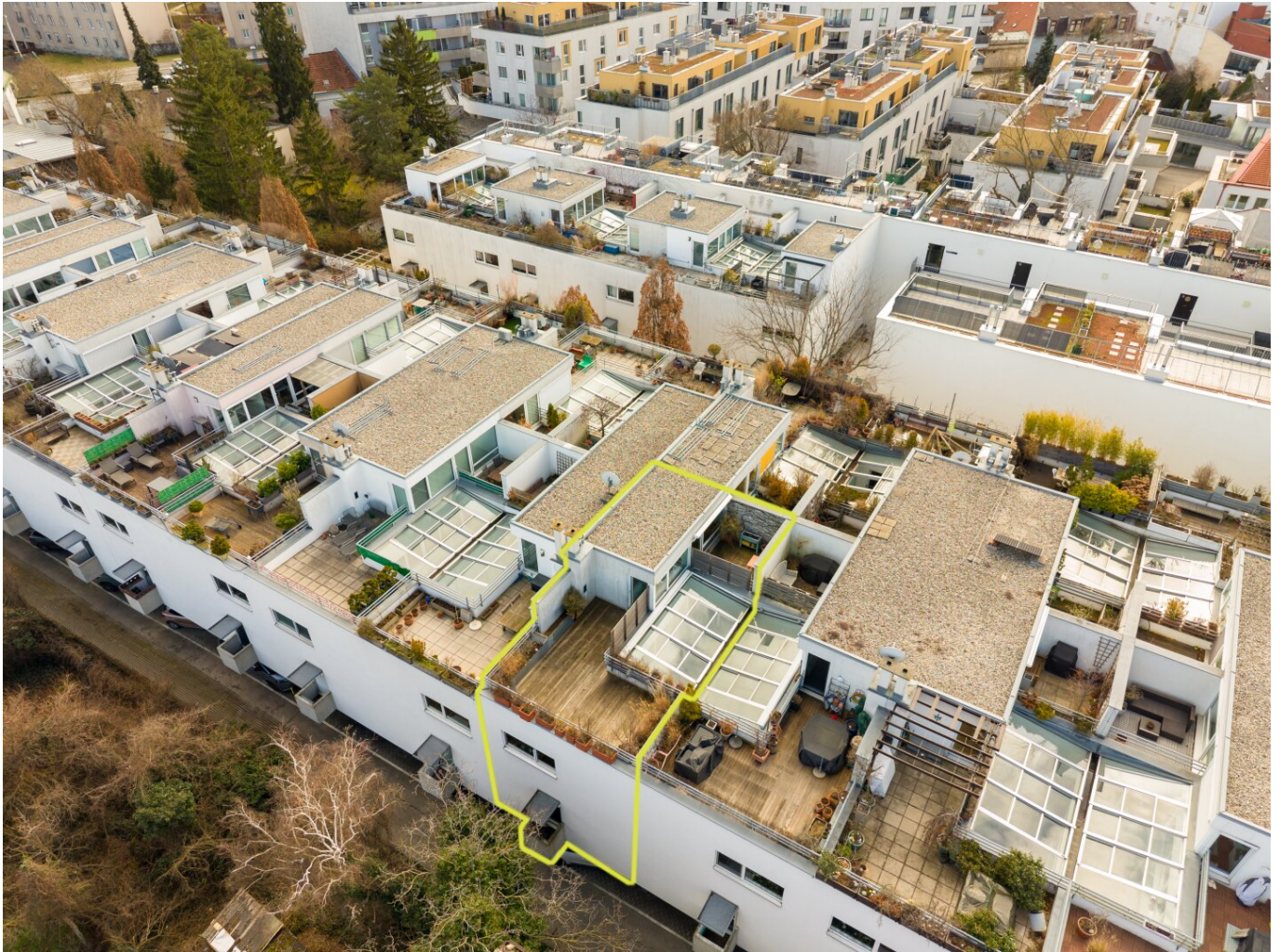
Anlage mit Markierung
