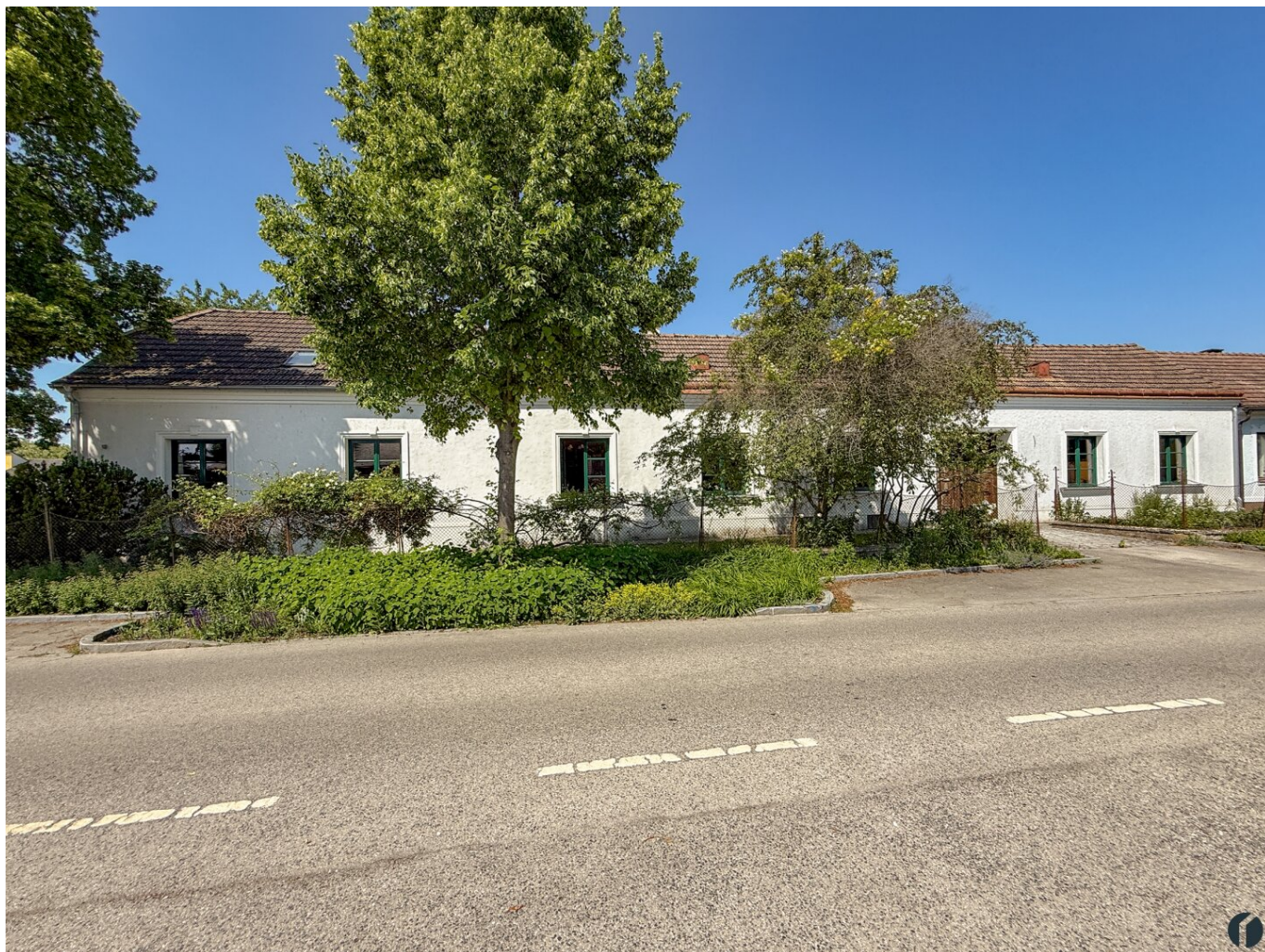
Außenansicht von der Straße aus
