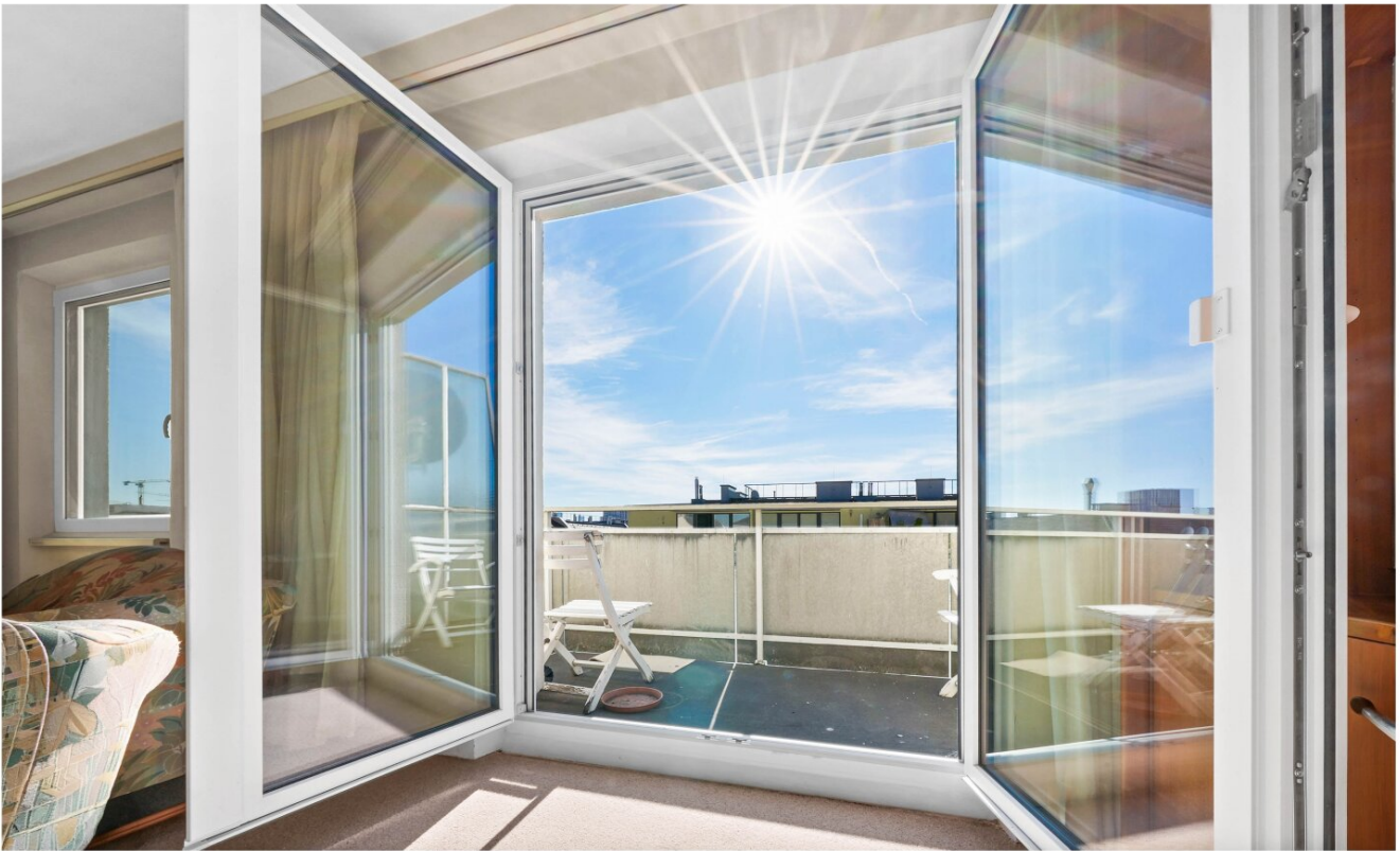
3-Fach Verglasung - im Mai 2026 wurden neue Fenster & Terrassentüren auf der Seite der Taborstraße eingebaut.
