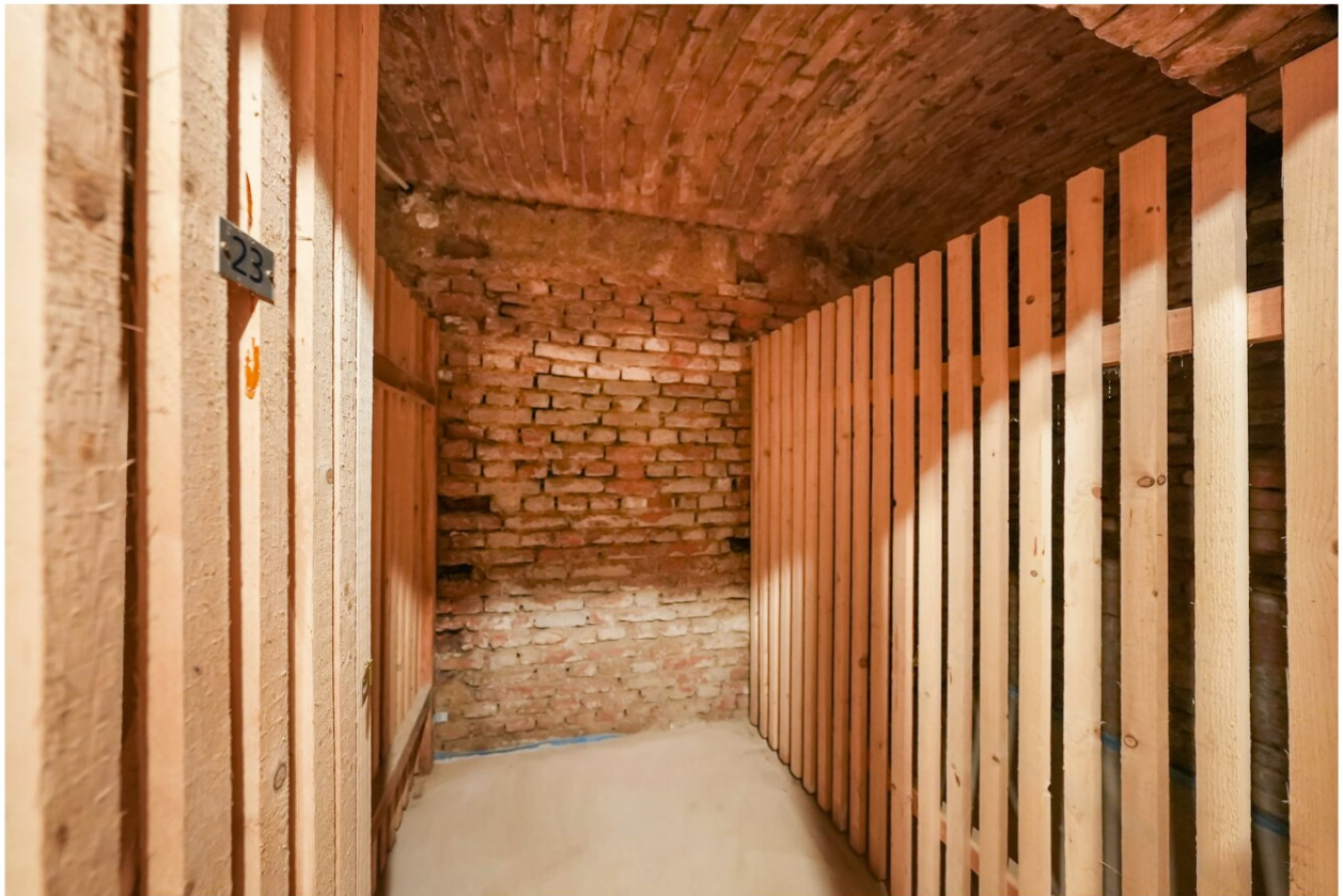
Das Foto zeigt das Kellerabteil der Top 23 im selben Haus Das Kellerabteil der Top 21 sieht ähnlich aus
