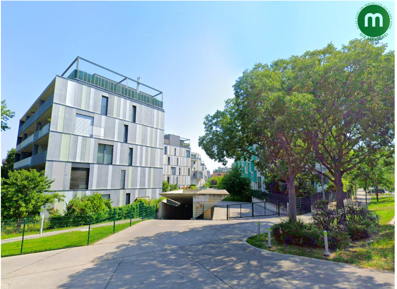
Zugang zur Anlage
