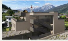
ROSSKOGEL Hatting Wohnanlage mit 6 Wohneinheiten
