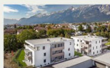
WEISSENBACH Mils Wohnanlage mit 16 Wohneinheiten
