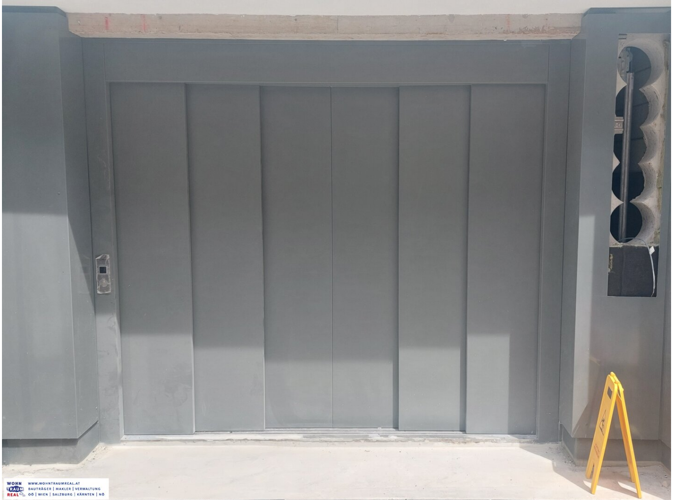
Tiefgarage mit Lift
