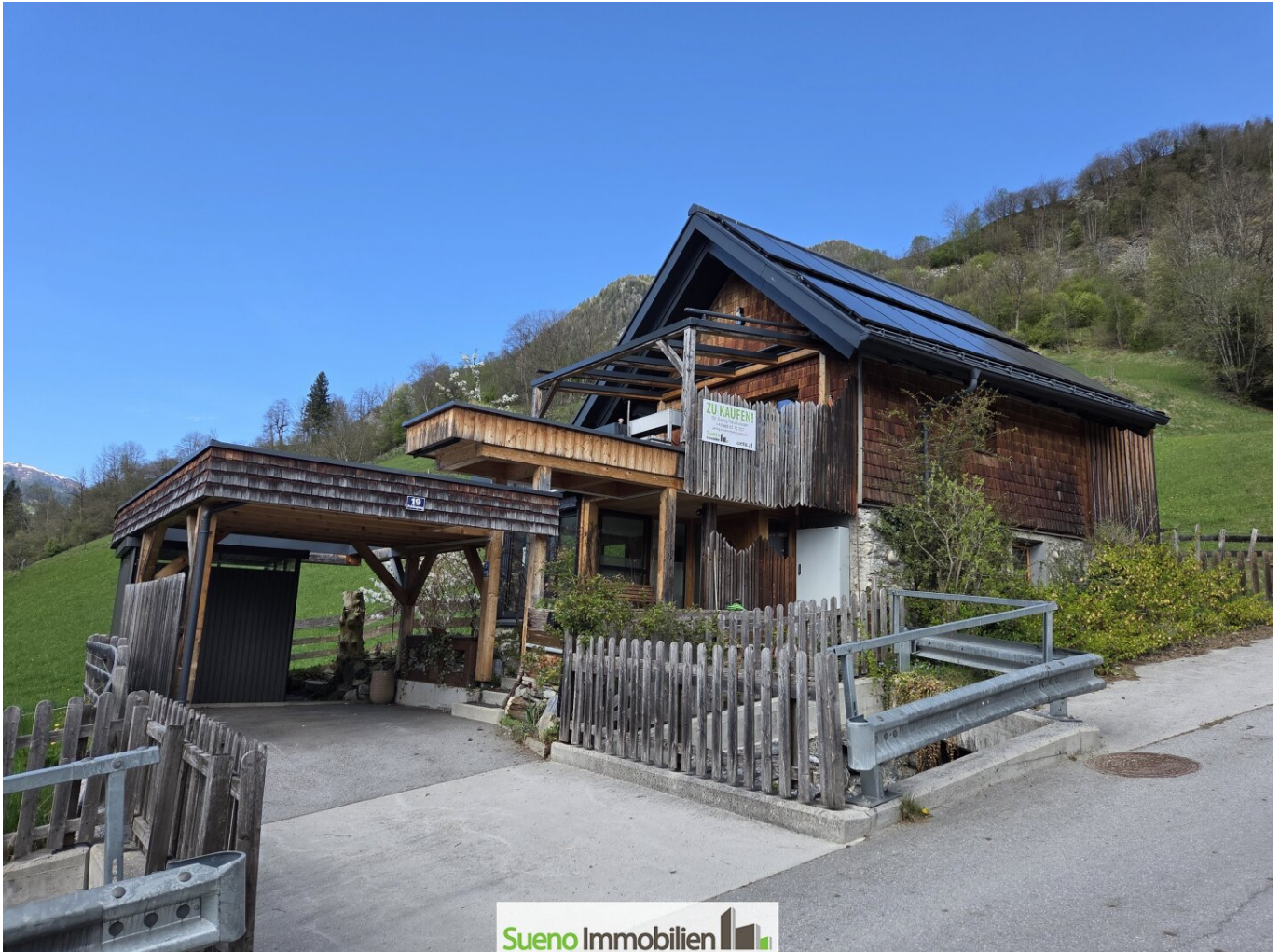
Hausansicht von Süden
