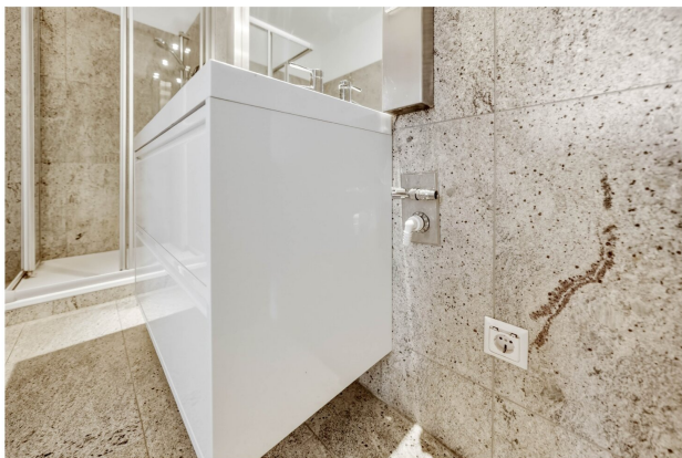
Waschmaschinenanschluss im Bad
