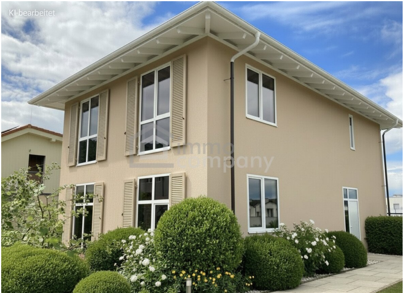
Ansicht außen Straßenseite
