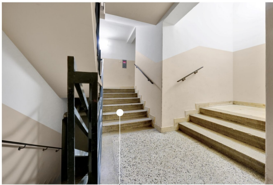
Stufen vor dem Lift im EG
