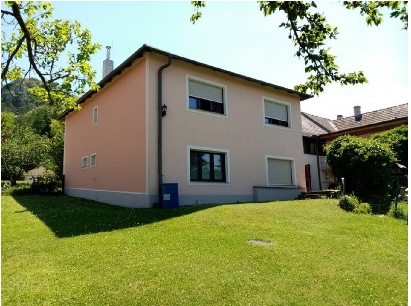
Gartenansicht Nordteil des Hauses
