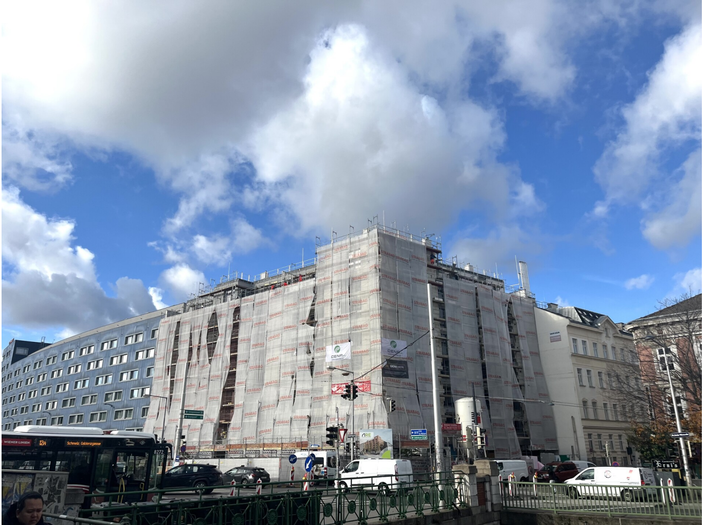
Fassade mit Gerüst
