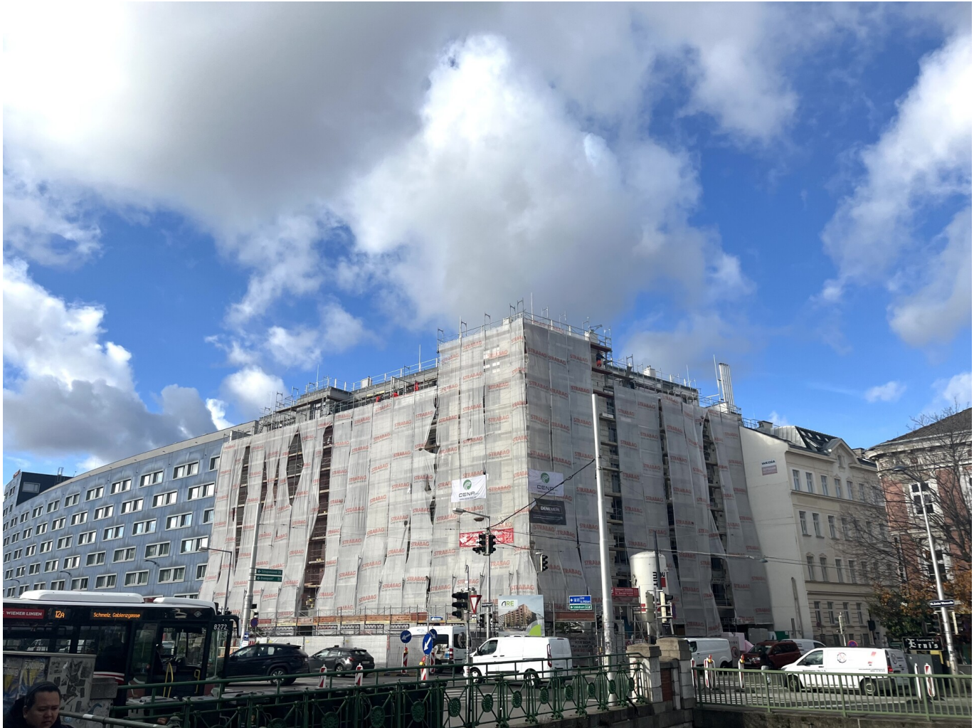
Fassade mit Gerüst
