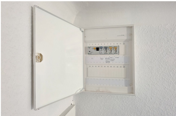
Sicherungskasten Elektrik
