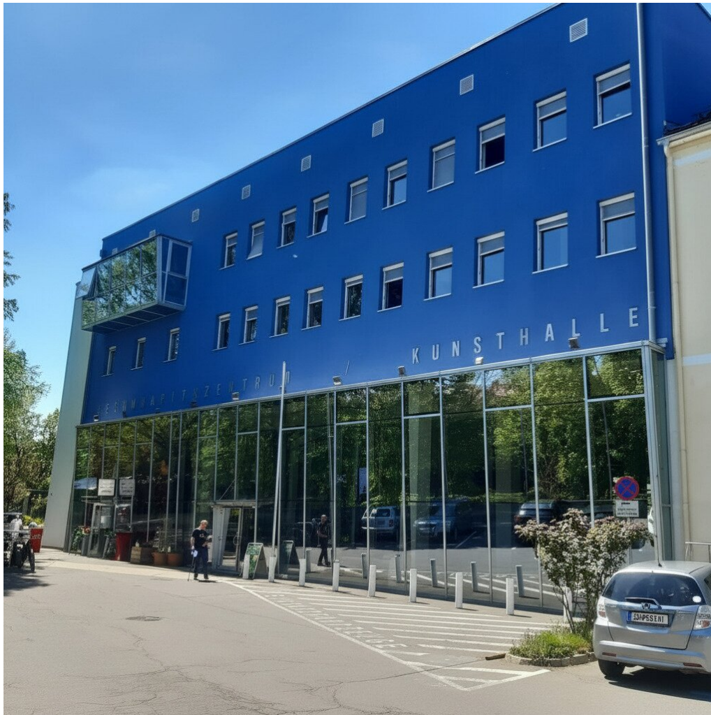
Gesundheitszentrum Feldbach - Außenansicht
