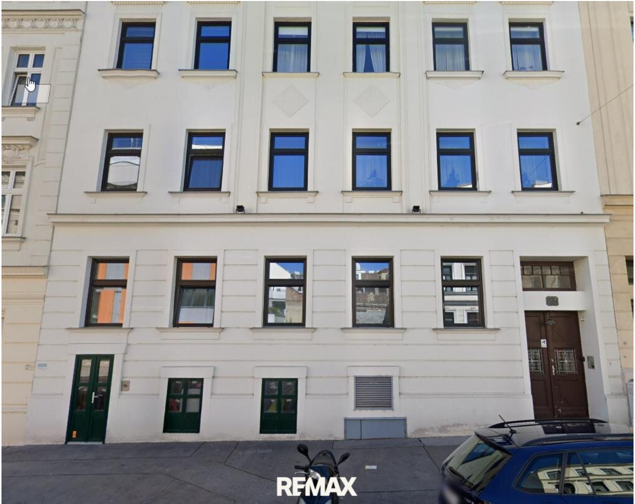
Gebäude von Aussen
