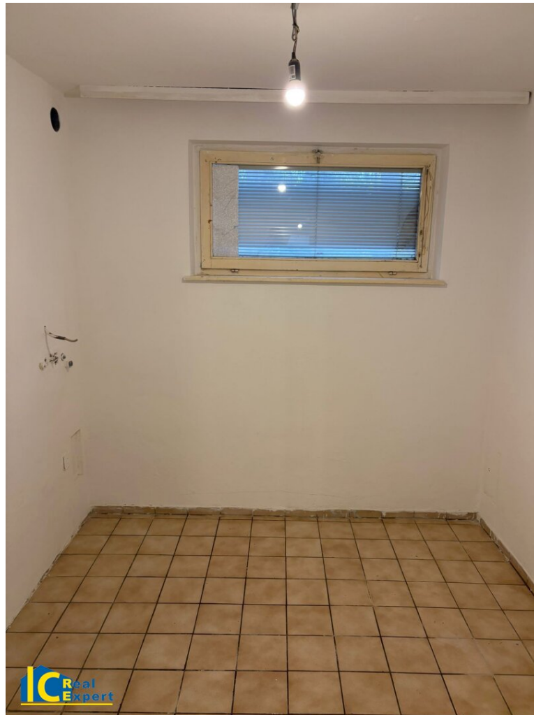
Abstellraum mit Tageslicht
