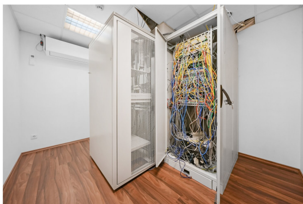
Serverraum mit Klima Splitgerät
