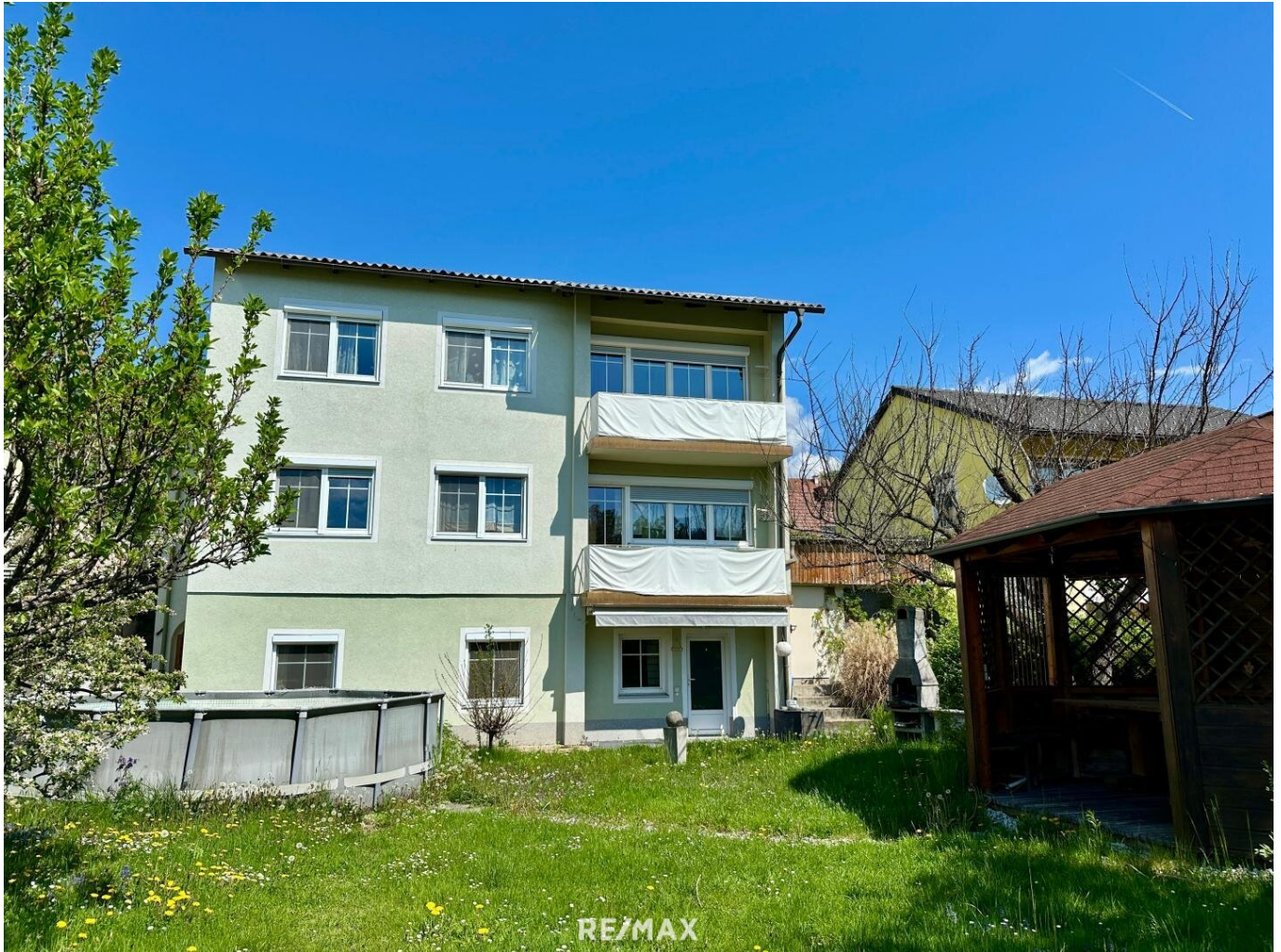
Mehrfamilienhaus in Strettweg
