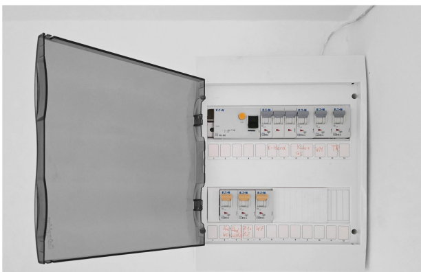
E-Sicherungskasten
