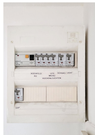
Elektro- Sicherungskasten
