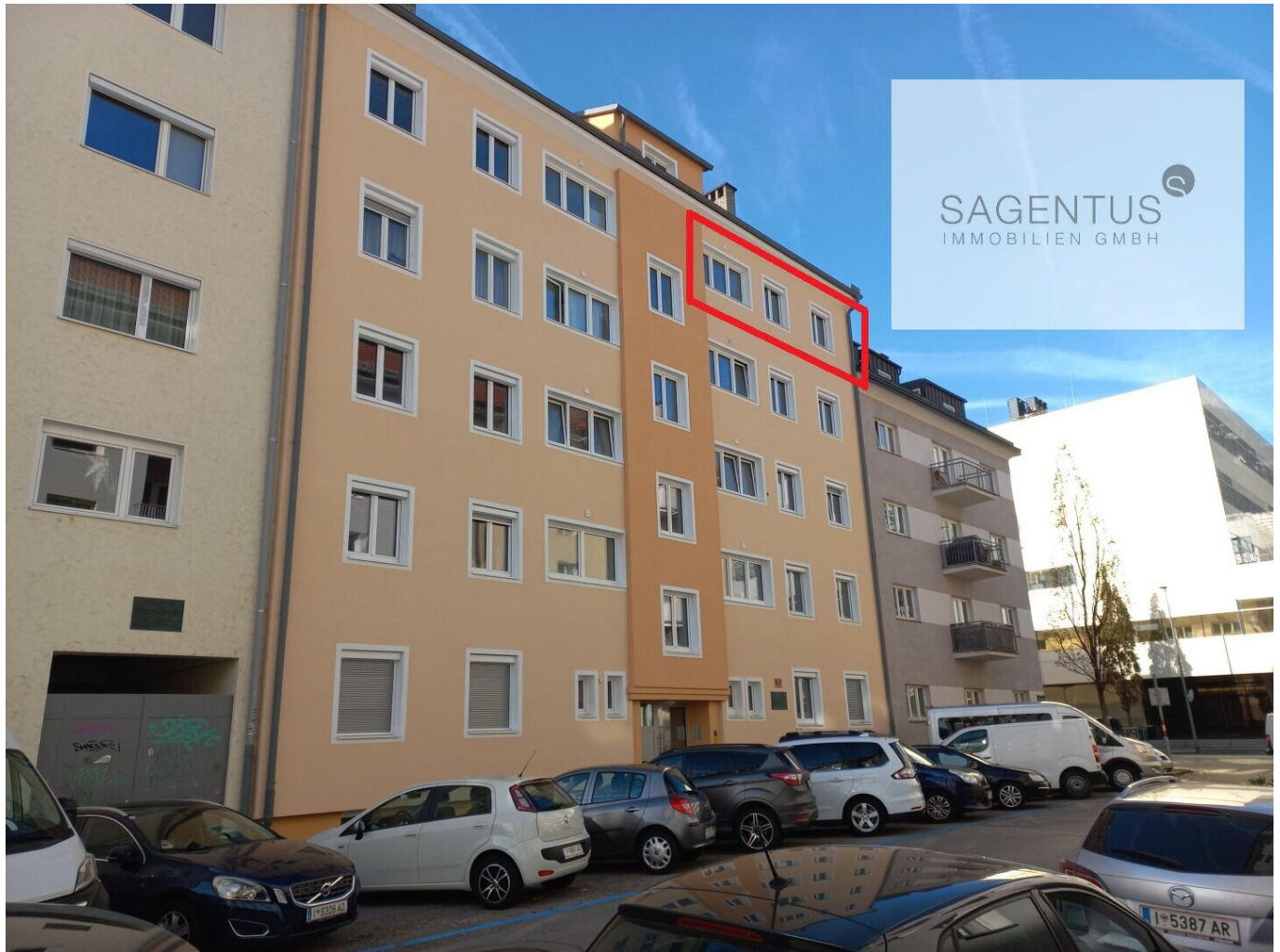
Außenansicht - Ing.-Thommen-Strasse, Innsbruck
