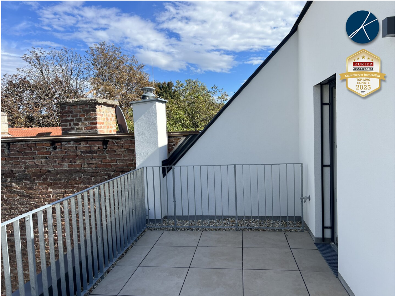
Dach-Terrasse Blick nach Osten
