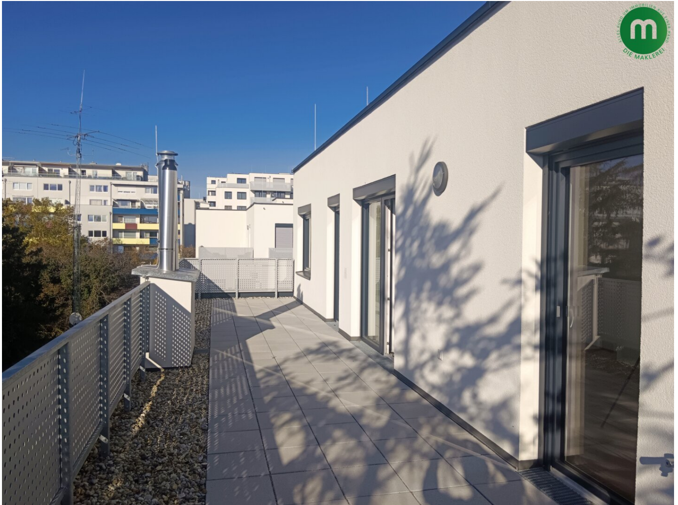
Terrasse - Blick Richtung Norden
