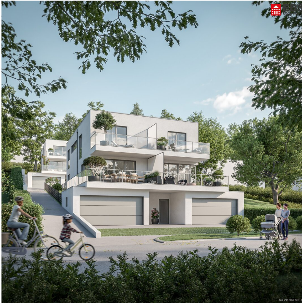
Ansicht Gebäude Süd
