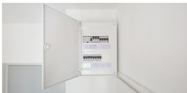
Elektro-Sicherungskasten
