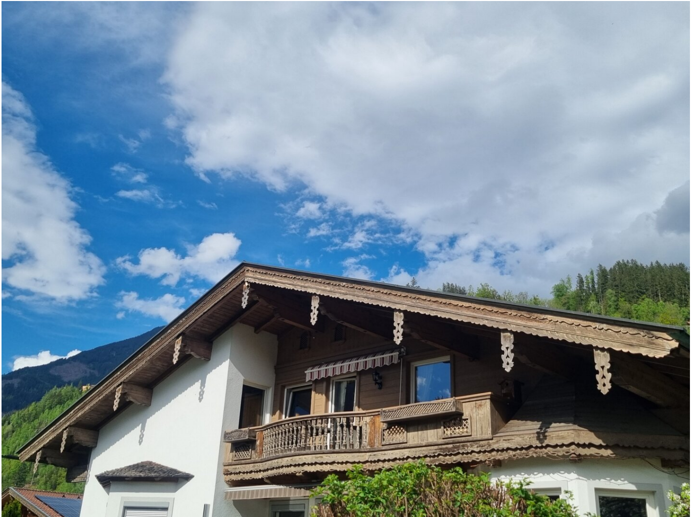
Aussenansicht der Wohnanlage Westseite
