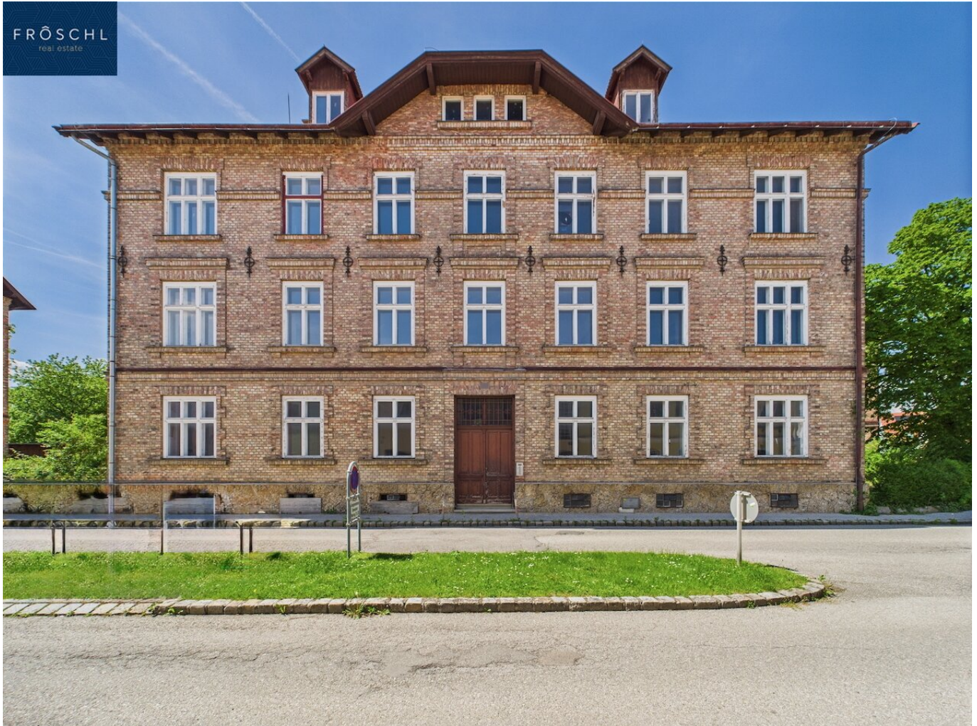
Ansicht Objekt Werksgasse 10
