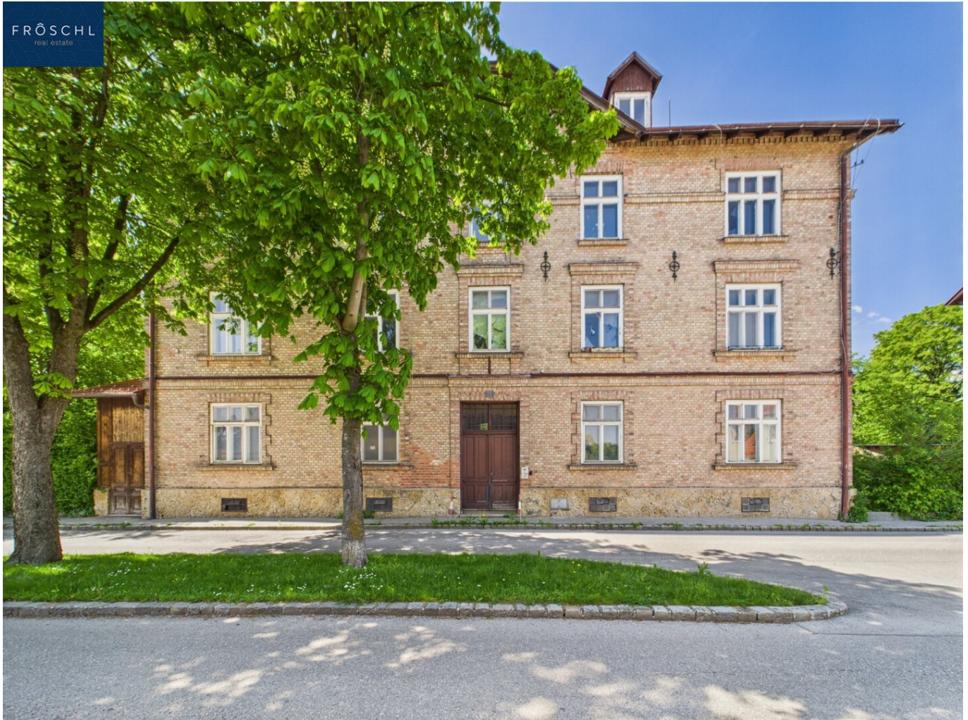
Ansicht Objekt Werksgasse 12 Pic 1
