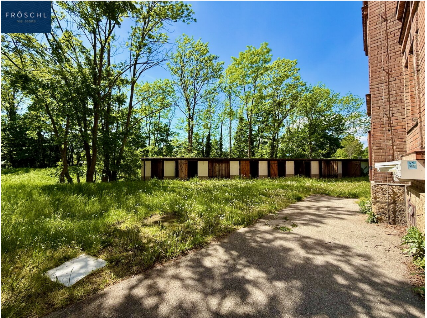
Ansicht Gartenseite - Objekt Werksgasse 8
