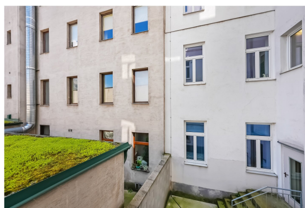
Blick Küche in den Innenhof
