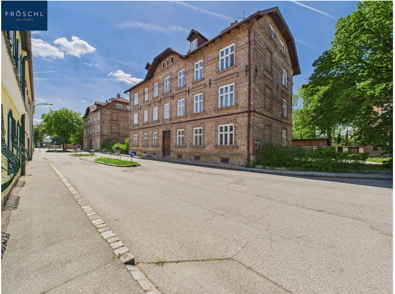
Ansicht Objekte Werksgasse 10 und 12
