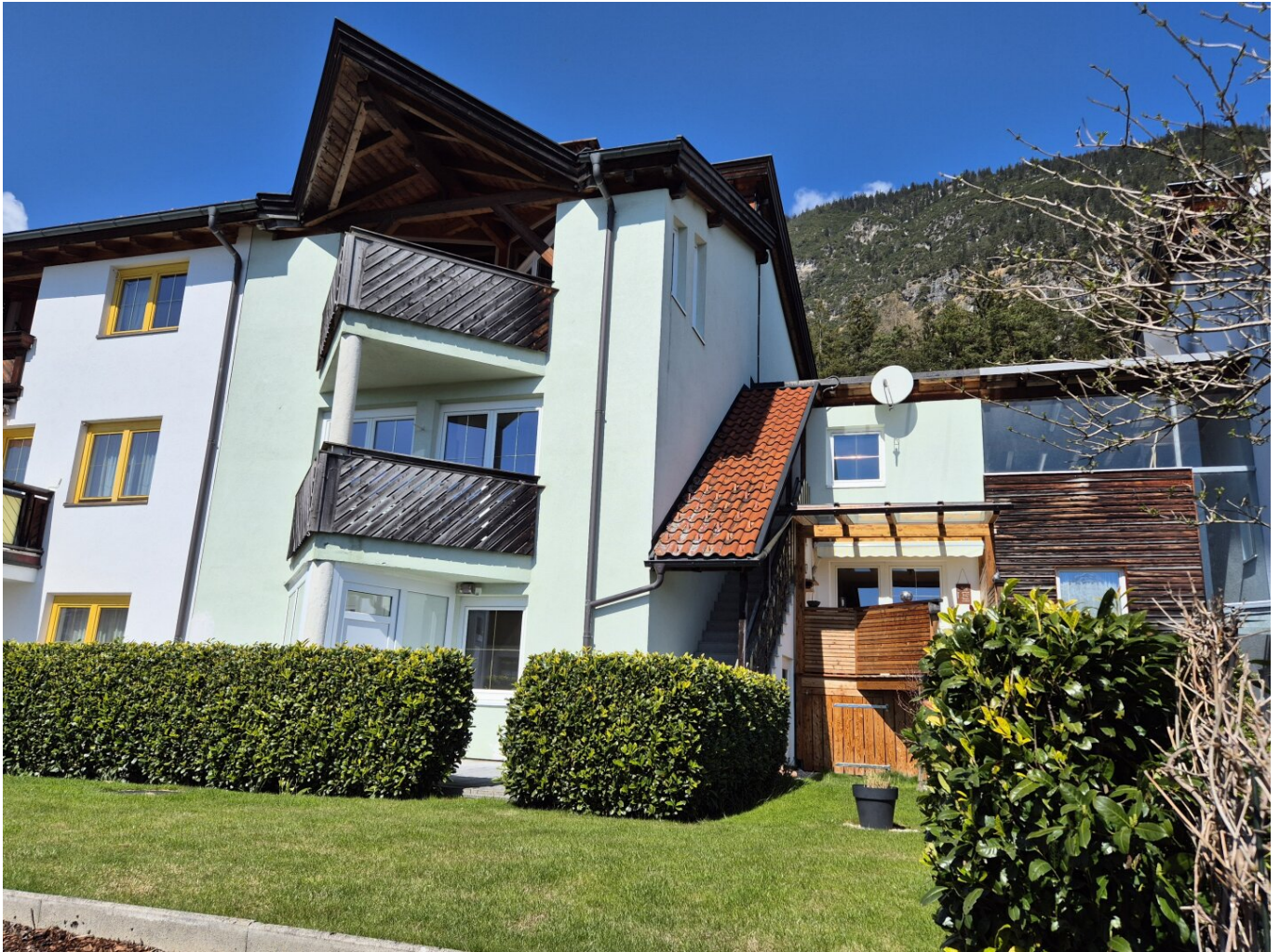
Außenansicht Südseite mit Garten und Terrasse
