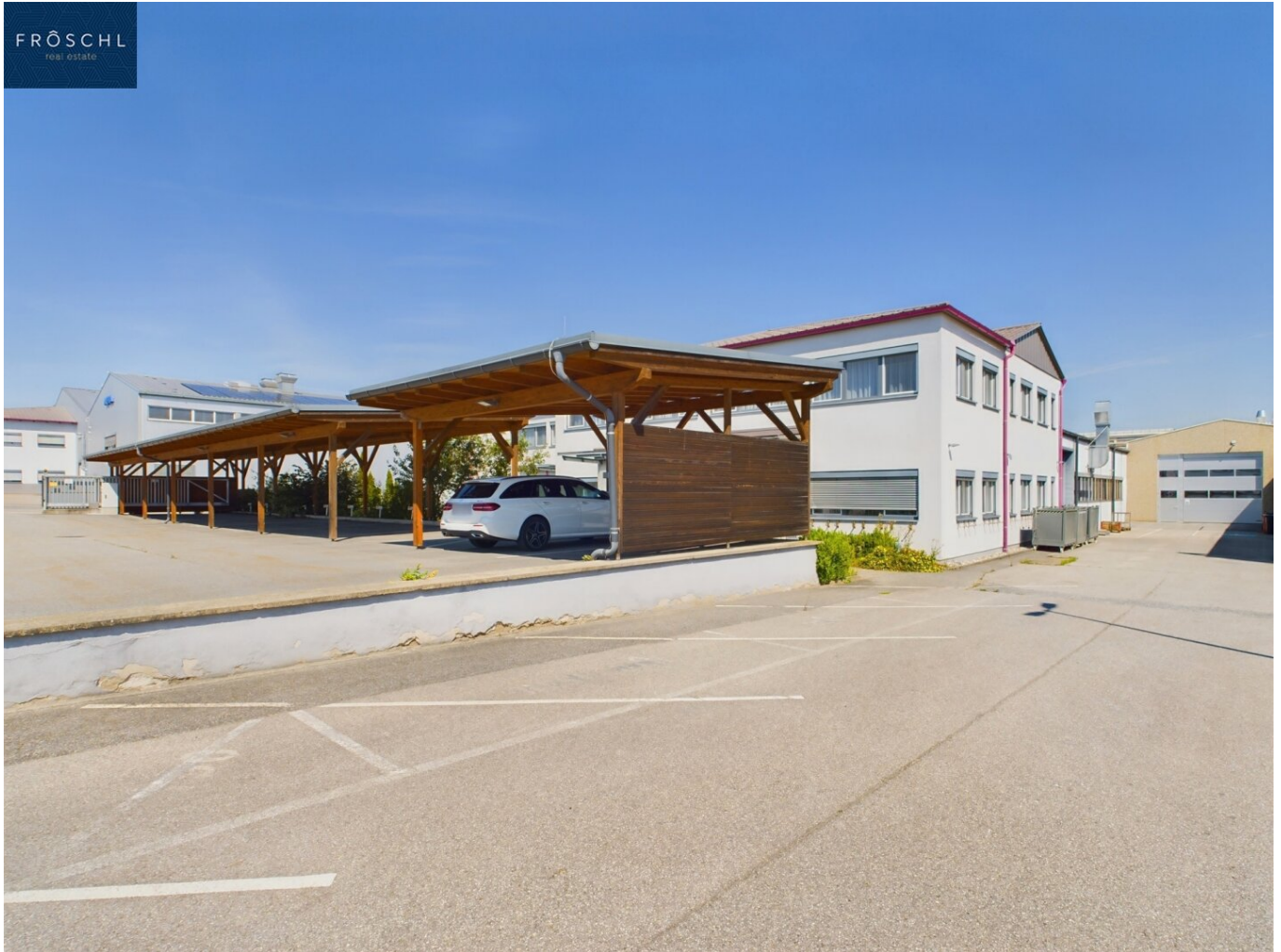
Außenansicht - Parkplatz / Hauseingang - Pic 1
