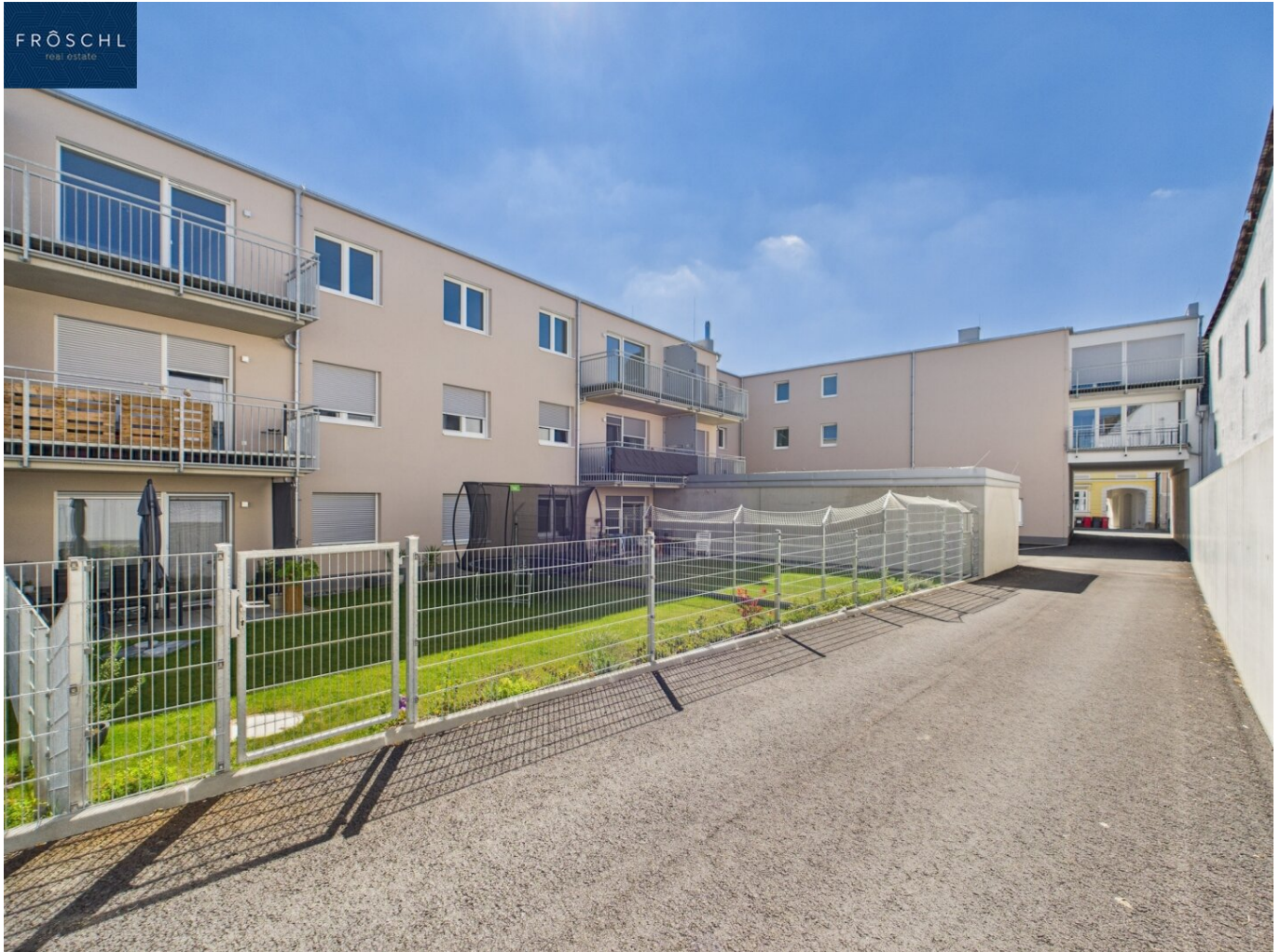
Ansicht der Gartenwohnungen - Pic 1
