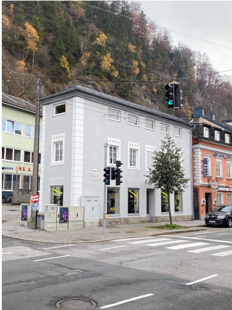
Ansicht - Neu saniertes und gut vermietetes Zinshaus Kauf Andräviertel Salzburg
